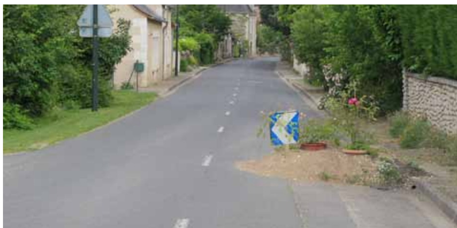
En entrée de village: mesure de modération provisoire originale, à tout petit prix! (Crédit CEREMA)
