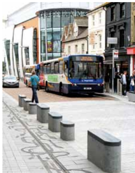
Espace partagé et art urbain: les méandres esquissés sur le trottoir servent à récolter les eaux de surface. Photo: Anne Jaluzot.
