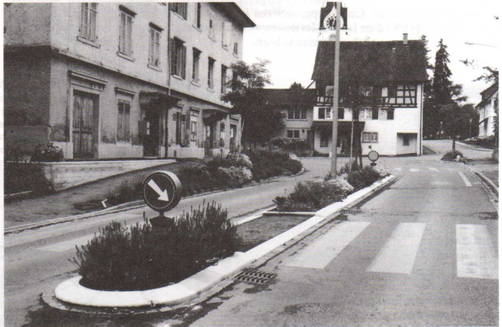
Oberrieden, ZH. L'amélioration des traversées piétonnes est une intervention de base sur les axes principaux. Il faut créer des refuges dignes de ce nom. Ici, le refuge a 1,80 m de largeur et les voies de circulation de part et d'autre n'ont que 3 m chacune.
