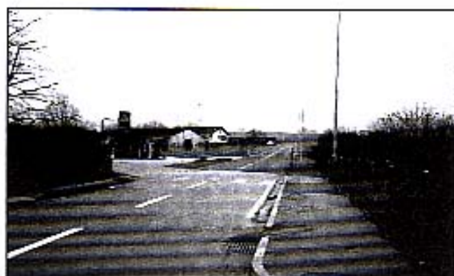
Route rectiligne et en descente: les voitures roulent trop vite à l'entrée de la localité, lieu important de passage des enfants.
