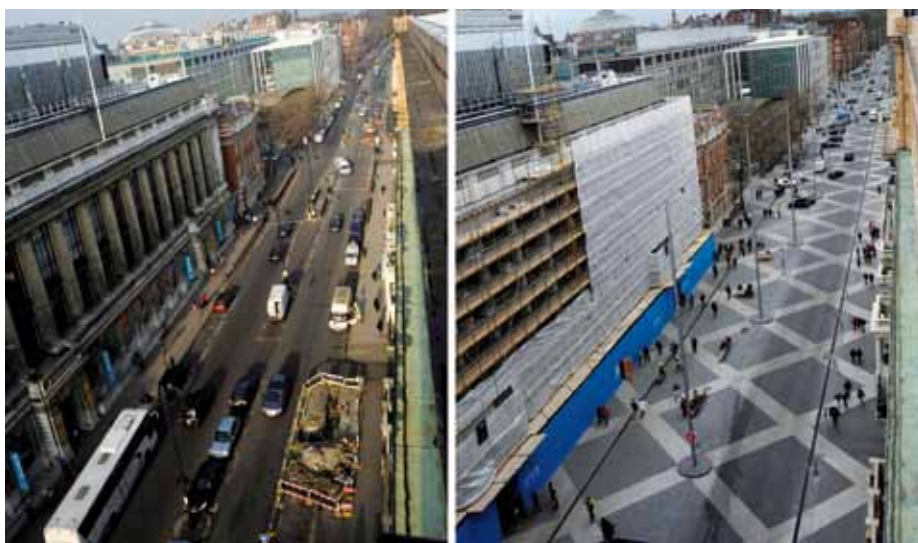
Londres: la transformation de Exhibition Street en «shared space» s'est faite selon les principes édictés dans le Manual for Streets . Photo: www.flickr.com / RBKC Exhibition Road
