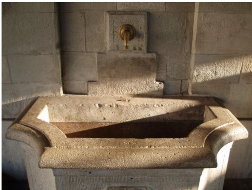
Abbildung 30: Der stillgelegte Trinkwasserbrunnen beim Bahnhof Brugg.
