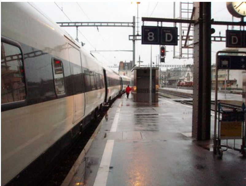
Abbildung 34: Periphere Perronbereiche sind oft nicht wettergeschützt.
