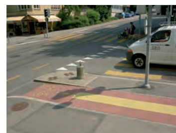
Zurich, au croisement de la Klosbachstrasse et de la Freiestrasse : une ligne jaune est dessinée sur la piste cyclable dans le prolongement du passage piéton ; les piétons sont donc prioritaires lorsqu'ils traversent la piste cyclable.
