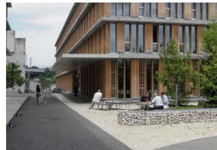
Un des sites des offices fédéraux à Ittigen (BE) L'aménagement des espaces entre les bâtiments est très apprécié pour les moments de pause.
