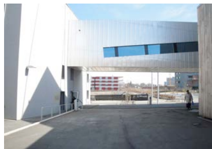
Westside (BE) Ouverture vers les quartiers voisins en construction.
