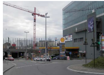
Malley Lumières, Prilly (VD) Situé dans un secteur en plein développement, le centre se trouve aujourd'hui au cœur d'une nouvelle interface de transport public : halte de RER, arrêts de bus, métro à 5 mn.
