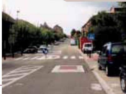
Le coussin : un moyen de ralentissement des voitures avant un passage pour piétons
