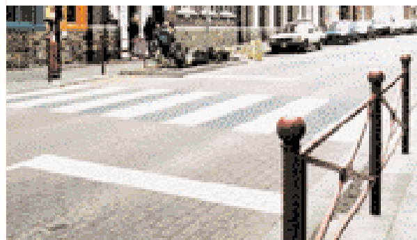
Une barrière empêche la traversée juste à côté du passage pour piétons.
