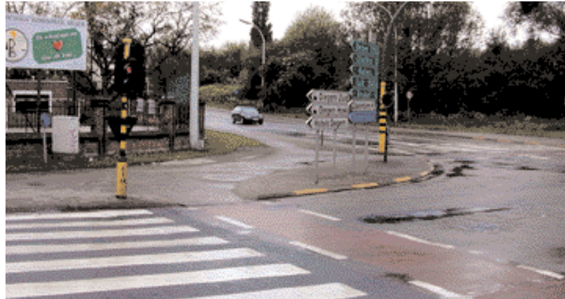
Un grand carrefour à feux, incluant une voie de pénétration : aménagements pour piétons et cyclistes indispensables!
