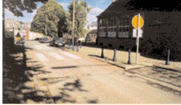
Des potelets empêchent le stationnement trop près du passage pour piétons.
