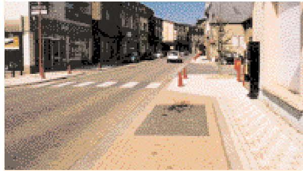
Un élargissement de trottoir à l'endroit de la traversée raccourcit le temps d'exposition au risque du piéton.
