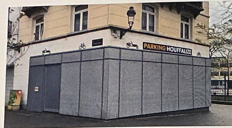
TRANSFORMATION DU BÂTI EXISTANT SOUS-UTILISÉ en parking vélo à Bruxelles (source : Martin Stock, cycloparking Bruxelles).
