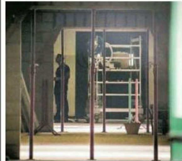
▲ I lavori Ultimi ritocchi in via Corelli
