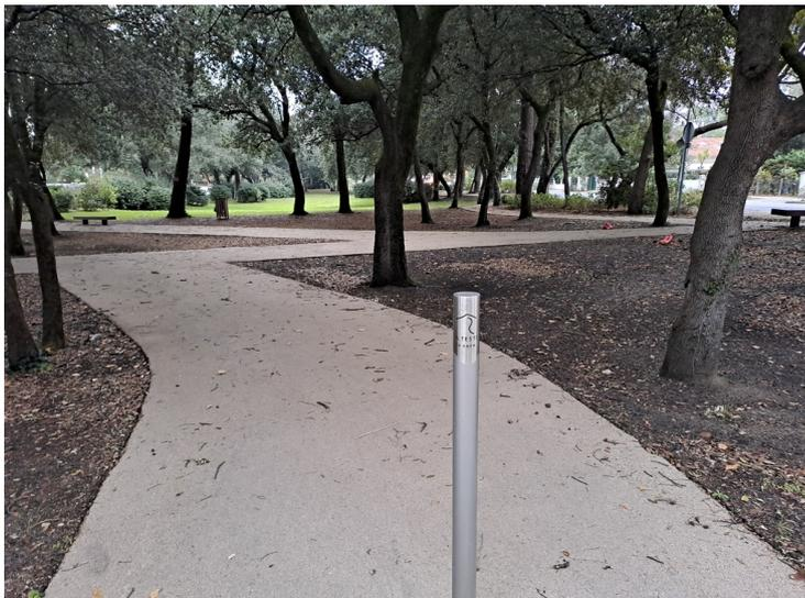
Illustration 59 : Place Meller au Pyla, bitume remplacé par un liant végétal
