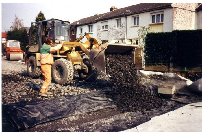
Illustrations 48 : Chaussée à structure réservoir avec enrobés poreux et trottoirs en pavés béton poreux (29 ans de vie utile)
