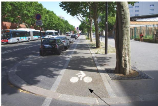
Une combinaison de matériaux perméables : revêtement poreux, pavés à joints engazonnés
