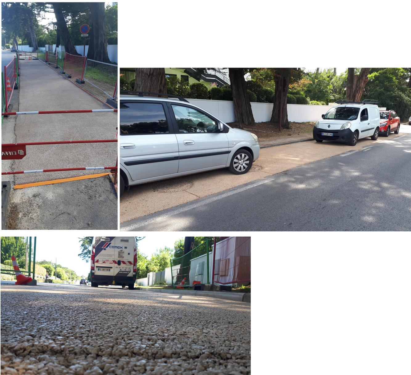
Illustration 113 : Béton perméable sur un site pilote de places de stationnement en voirie
