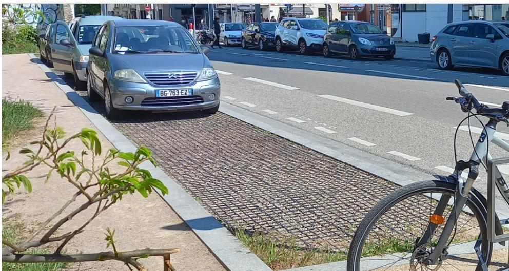
Illustration 110 : Dalles PVC alvéolées avec remplissage gravier sur bande de stationnement
