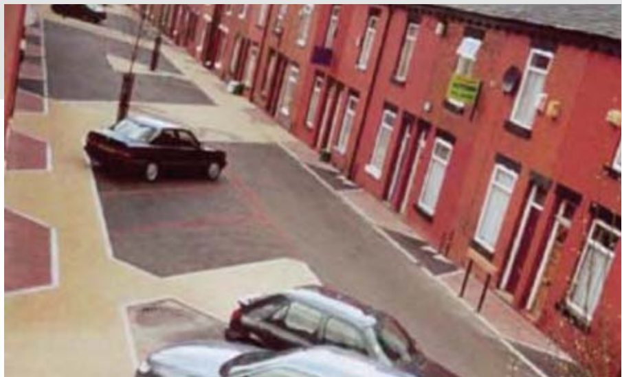
Royaume Uni - La zone de Northmoor à Manchester a connu une réelle amélioration des conditions de vie et de la qualité de son espace public.
