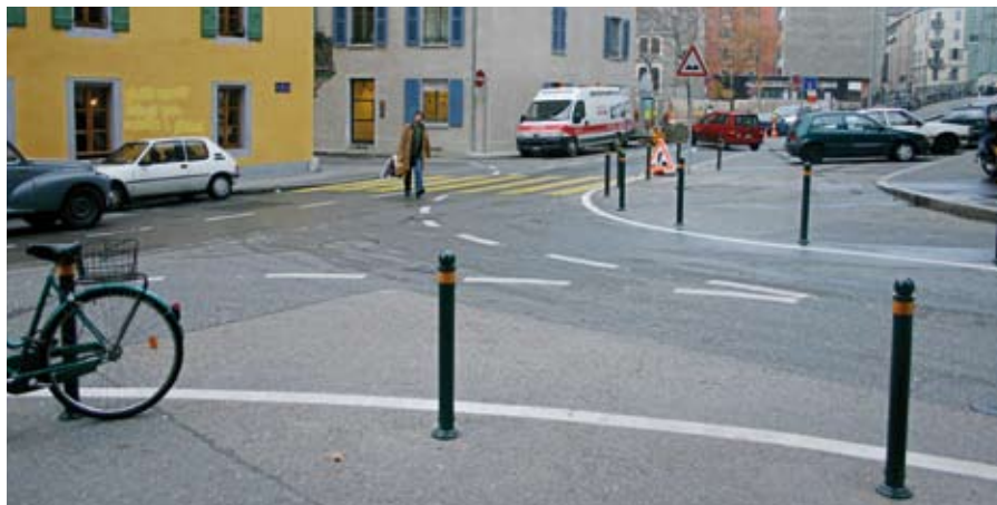
Carrefour le long de la rue Prévost-Martin. Le passage piéton qui avait dû être effacé a été repeint après coup, l'emprise du carrefour a été réduite (marquage et potelets) et un coussin berlinois aménagé vers le passage piéton.
