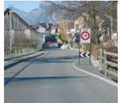
Les mesures sont légères: rétrécissement aux entrées, rétablissement de la priorité de droite aux carrefours, marquages au sol, pour un coût total (planification et réalisation) de 80 000 francs.
