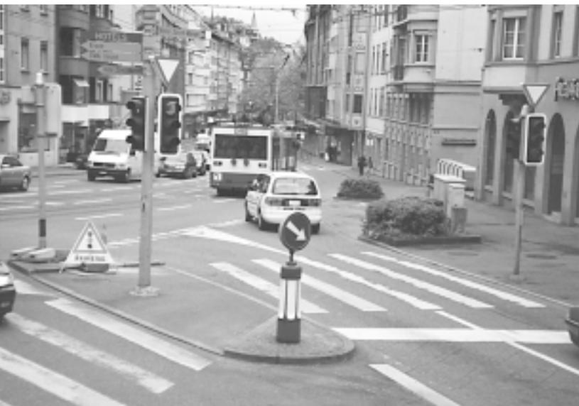
**Stampfenbachstrasse-Wasserwerkstrasse.** Lorsque deux, voire trois, véhicules de transport public s'approchent en même temps d'un carrefour, le programme donne la priorité à l'un ou à l'autre suivant des paramètres prédéfinis. Ici le bus vient de s'engager sur la voie principale : il a obtenu la phase verte immédiatement après le passage du tram en descente sur la voie principale, et emprunte la voie mixte tram-bus.
