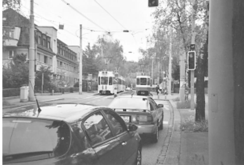
**Arrêt de tram Laubiweg.** L'arrêt a été réaménagé pour un meilleur confort des usagers du tram, qui n'ont plus besoin de traverser la chaussée pour atteindre le véhicule à l'arrêt. Quand un tram se trouve à l'arrêt, les voitures attendent au feu, puis empruntent la voie du tram une fois celui-ci reparti.
