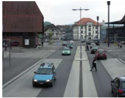
KÖNIZ – après: diminution du gabarit de la chaussée, abaissement de la vitesse autorisée à 30 km/h dans le centre, suppression des passages piétons, giratoire en traversée libre pour les piétons.
