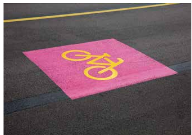
Jalon posé au sol plusieurs fois sur le tronçon : la répétition donne une bonne visibilité à tous les usagers
