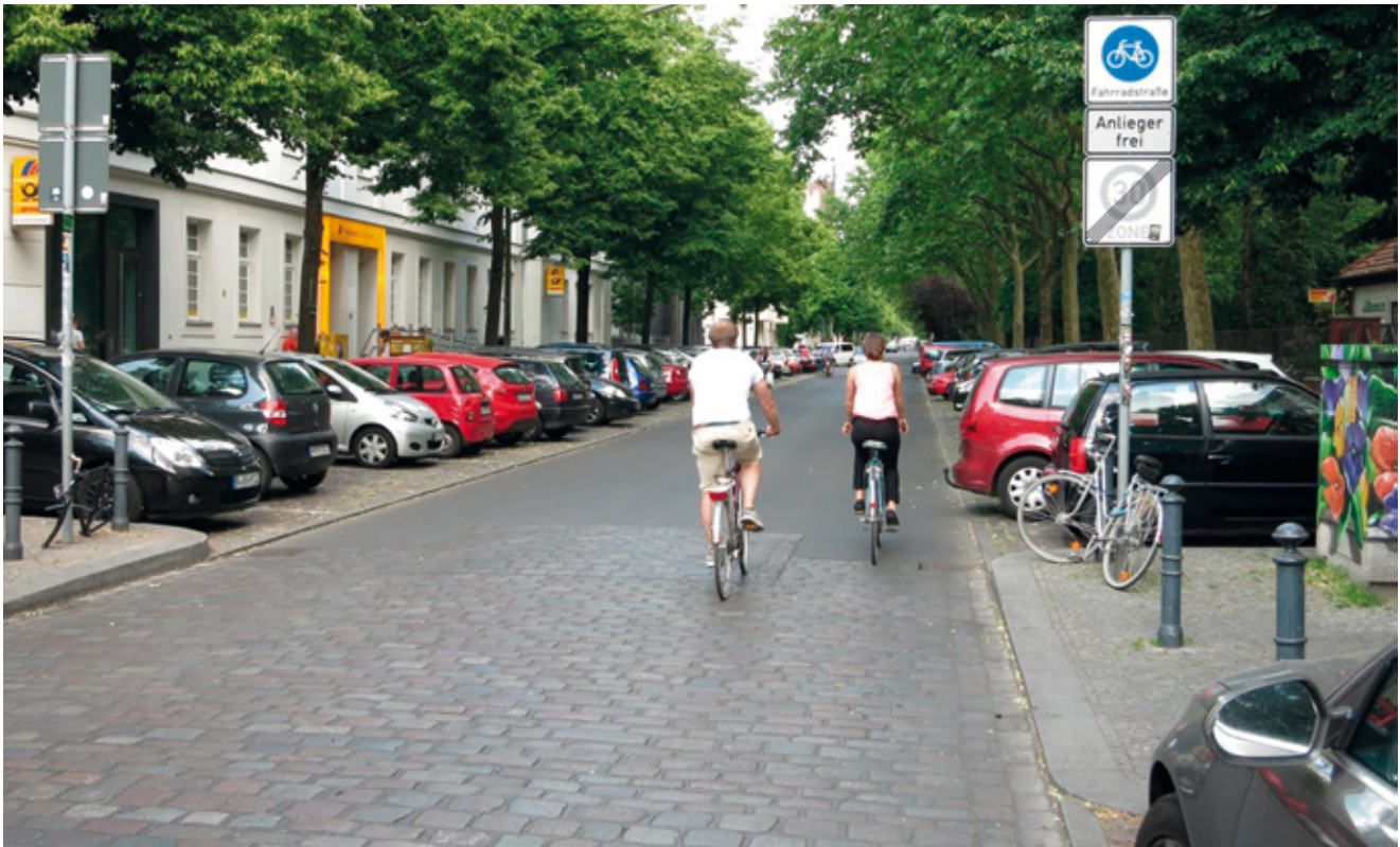
Rue cyclable à Berlin ; le pavage et le décrochement vertical en milieu de chaussée servent à modérer le trafic (« coussin berlinois »).
