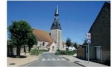
Ici, l'entrée de la zone 30 est marquée par une réduction de la largeur de la chaussée ainsi qu'une auvent. Des végétations basses (pour conserver la visibilité) sont ajoutées renforçant le rétroéclairage de la chaussée et changeant l'ambiance de la rue.
