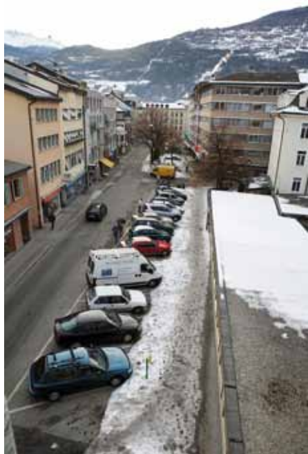
Espace des Remparts - avant...
