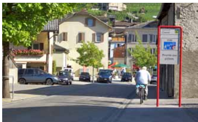
Des aménagements de zones de rencontre permettant la cohabitation à Charrat.
