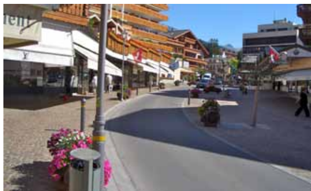
Zone 30 à Crans-Montana, aménagement peu contraignant pour le déblaiement des neiges à 1'500 m.
