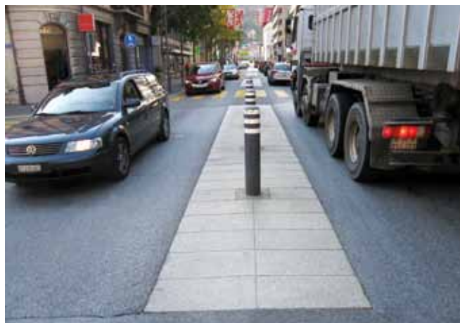
L'idée du réaménagement consistait à réduire la largeur de la chaussée d'un point de vue optique et à améliorer les traversées piétonnes. La largeur des voies est de 3,70m et de 4,20m là où il y a des bandes cyclables. (Photo Andreas Stäheli)
