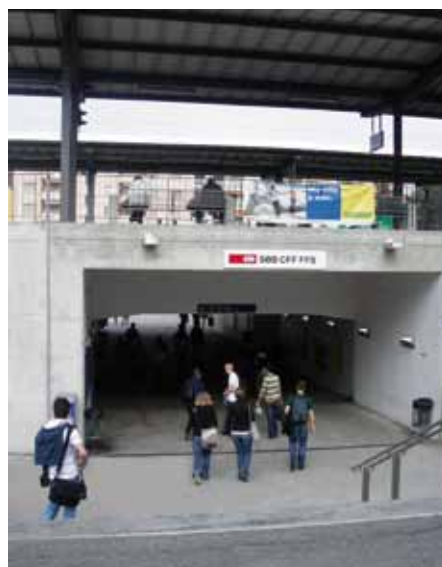
Gare de Nyon, le passage sous-voie récemment élargi facilite la circulation des piétons de part et d'autre des voies.
