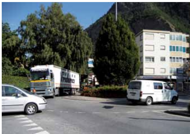
En dépit de la charge élevée de trafic et du grand nombre de camions, les giratoires ont un diamètre de 26-28 m et une seule voie de circulation. (Photo Andreas Stäheli)
