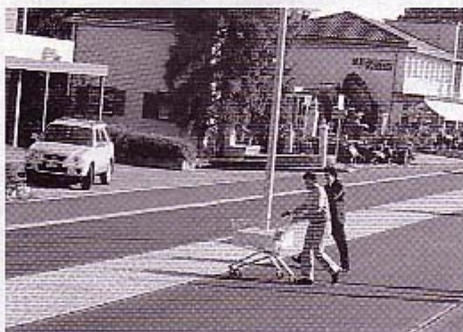
L'aménagement comprend des trottoirs de 2 à 2,5 m, une chaussée de 3, 4 m et une bande polyvalente centrale d'environ 2 m. La présence de luminaires sur la bande polyvalente garantit qu'elle sera bien utilisée pour les tournés à gauche ou à droite.
