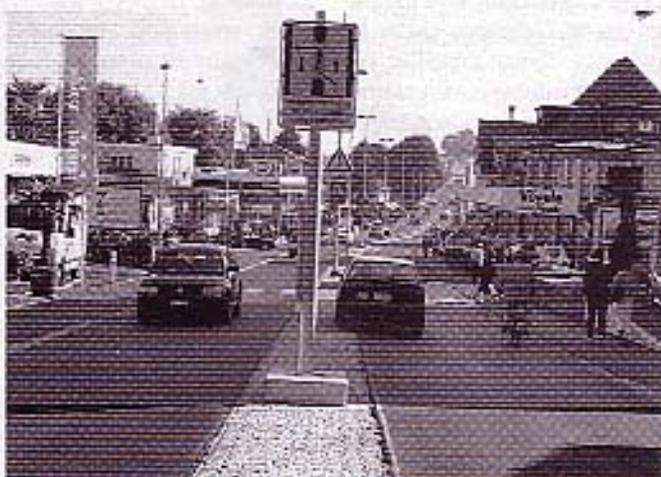
La faible largeur de la chaussée incite l'automobiliste à doubler les deux-roues en empruntant la bande polyvalente, ce qui l'oblige à rouler à une vitesse mesurée.
