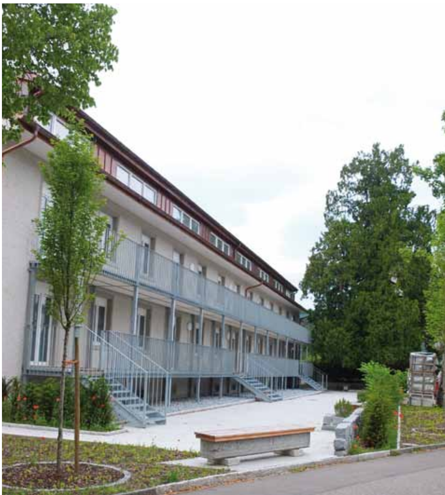
Effet domino: les autorités de Turgi récoltent aujourd'hui les fruits de leurs efforts sur la rénovation des fronts de rue de plusieurs bâtiments du centre. (Photo: Cédric Boussuge, CEREMA)
