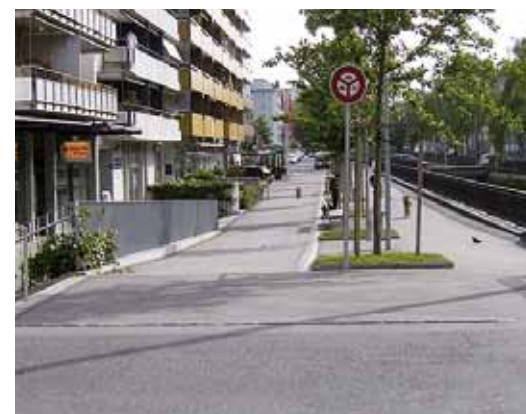
Bienne, Quai du Haut. Un «cas limite», où la ségrégation entre piétons et cycles, réintroduite pour améliorer la sécurité, induit au final moins d'attention vis-à-vis des piétons et une perte globale de convivialité. (Photo Pierre Chanez)
