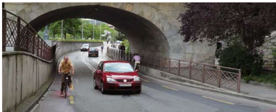
Quai du Sujet à Genève. Bandes cyclables 1.20m et voie centrale de 4.50m. Photo: J. Barbey, 2008.
