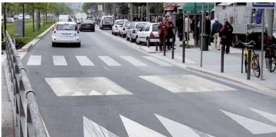
**Grenoble (F).** Exemple d'aménagement de coussins berlinois doubles: le dispositif est dimensionné de manière à avoir un effet ralentisseur pour les voitures mais permettre le franchissement à niveau par les gros véhicules. (Photo D. von der Mühl)
