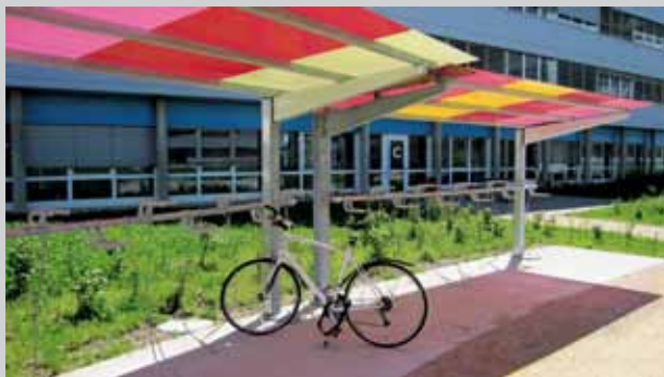
Le quartier de l'innovation à l'EPFL: un exemple de stationnement vélos couvert «customisé» fait à partir d'une structure classique: la couverture est faite de scobalite coloré éclairé par des LED dont l'intensité varie en fonction de la force du vent.
