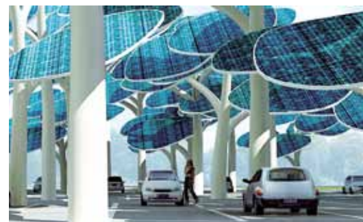
Solar Forest: Les places de stationnement sont équipées de panneaux solaires qui permettent d'alimenter les voitures électriques. Quel avantage pour l'espace public? Les panneaux solaires permettent de garder les voitures à l'ombre! Source: cyborglandscapes.blogspot.com
