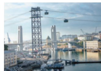
Téléphérique de Brest. (source : Interface)
