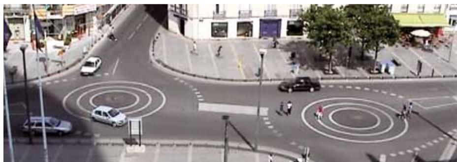
**Nantes, Cours des 50 Otages.** Un dispositif de ronds-points doubles sur cet axe principal autrefois à neuf voies, désormais recalibré, réaménagé et limité à 30 km/h. Le projet a été élaboré en collaboration avec l'architecte Italo Rota (Extrait vidéo, Yan Le Gal).
