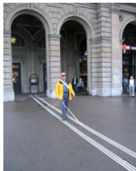
Zürich, Bahnhofquai, ligne de guidage à l'entrée de la gare principale. Crédit photos: Centre suisse pour la construction adaptée aux handicapés
