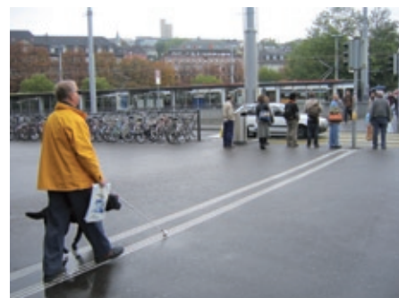
Zürich, Bahnhofquai, ligne de guidage menant au poteau avec le dispositif tactile pour le feu de signalisation.
