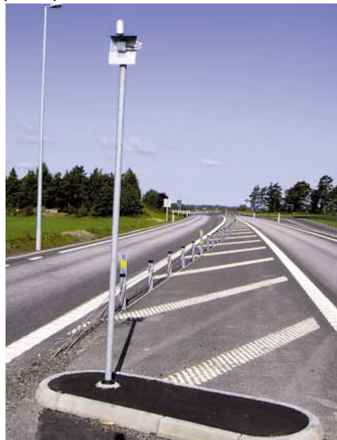
Détecteur de piéton (sur une route à 90km/h). Il informe les automobilistes de la présence de piéton et les incite à ralentir. A noter que ces poteaux sont conçus pour ne pas résister aux chocs.
