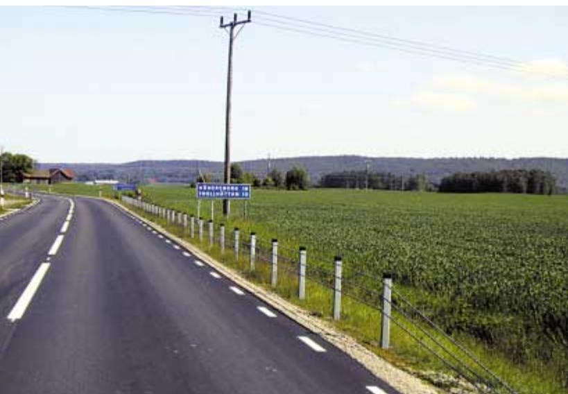
Routes 42/2020 (70km/h). Route sans séparation centrale. La banquette herbeuse est adoucie, les obstacles potentiels, comme le poteau sur la photo ci-dessous, sont protégés par des câbles qui remplacent les glissières.
