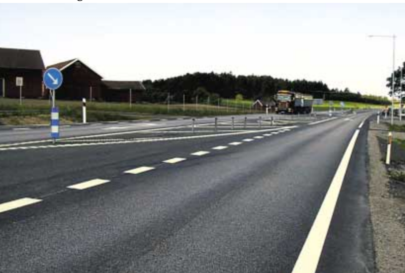
Route 44 (90km/h). Route avec séparation centrale (câblage), accès minimisés, limitation des tournés à gauche, 2 voies ponctuelles pour les dépassements, giratoires.
