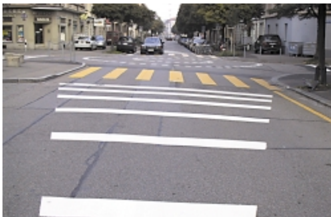
Ralentisseur visuel. Marquage au sol et pastille visuelle. La police zurichoise indique que ce type de ralentisseur visuel est efficace.
