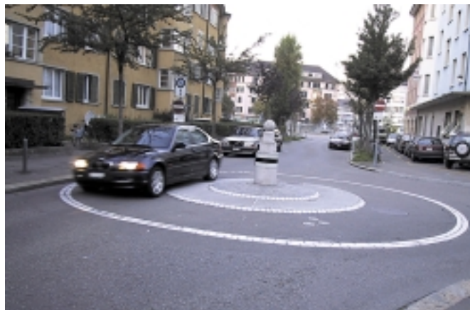
Mesure constructive. Mini rond-point avec double pastille rehaussée et totem. Très efficace. Coût: Fr. 12700.- (pastille rehaussée simple: Fr. 7000.-).
