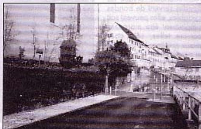
Après. Le système des banquettes herbeuses permet de mettre en évidence cette traversée structurante. C'est aussi le seul endroit où la chaussée est pavée, avec un très léger décrochement vertical. Quatre arbres marquent le point de passage.
