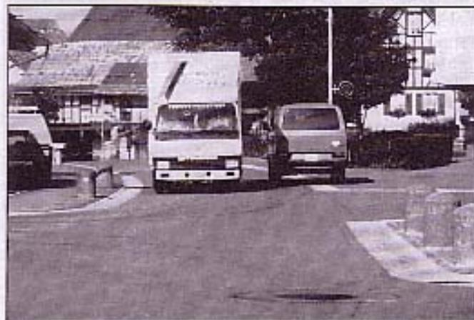
**Uitikon près de Zurich, route cantonale avec près de 6000 véhicules/jour. La chaussée de 4 m est bordée de deux rigoles de 55 cm. Projet et réalisation: Metron.**
