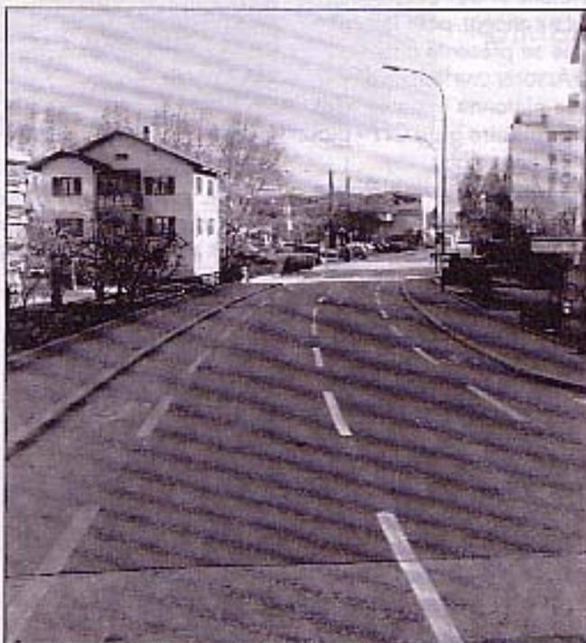
**Bandes cyclables polyvalentes sur la rue de St-Guérin à Sion (route collectrice et axe deux-roues). Largeur de la chaussée: 4,50 m, bandes cyclables: 2 x 1,25 (projet Transportplan).**
