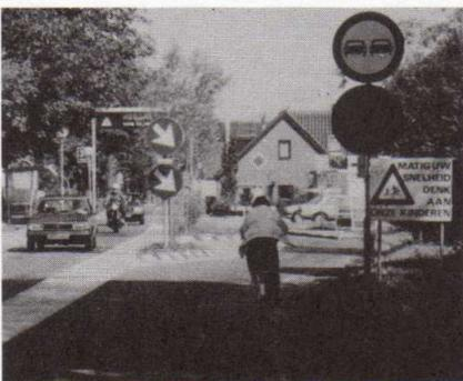
La porte d'entrée en localité. A noter les dimensions très réduites des voies de part et d'autre de l'îlot. La vitesse moyenne y a baissé de 20% (avant: 54 km/h, après: 43 km/h).
