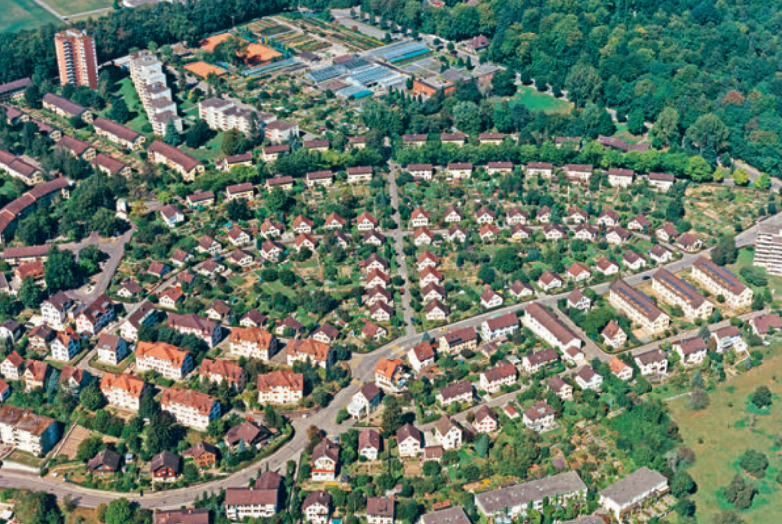
📍 En ville de Schaffhouse, des stratégies d'incitation pour revaloriser les biens immobiliers en mains privées ont été mises au point.
