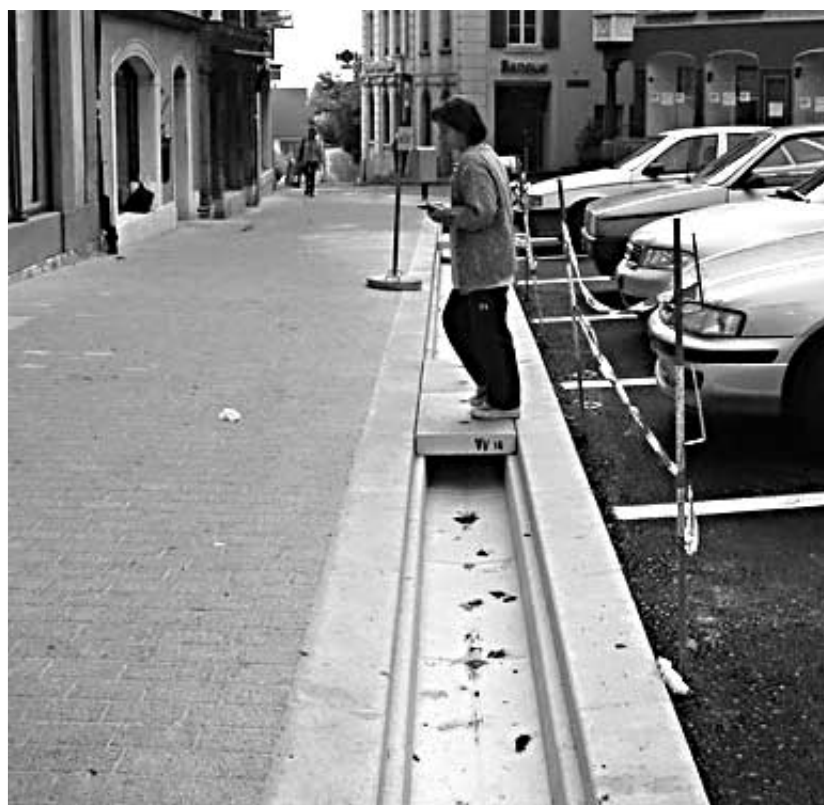
Le canal de la Doux le long de la rue Pierre-Péquignat.
