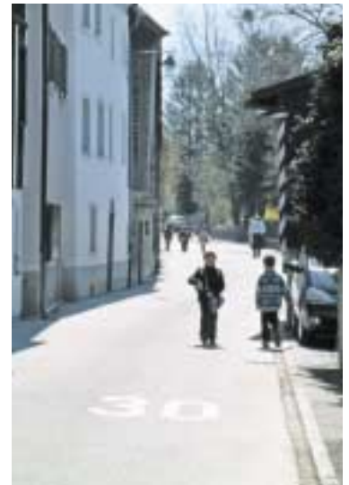
Les mesures sont légères: rétrécissement aux entrées, rétablissement de la priorité de droite aux carrefours, marquages au sol, pour un coût total (planification et réalisation) de 80 000 francs.
