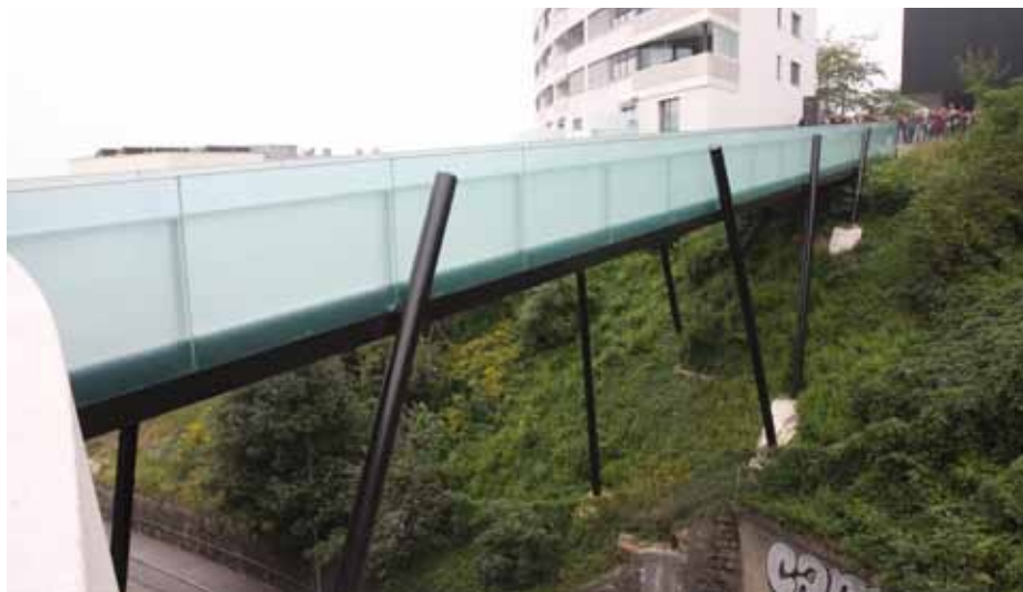
La passerelle du Millénaire , inaugurée en 2013, permet de franchir un fort dénivelé et de relier différents sites de formation. 400 personnes sont attendues aux heures de pointe, avec une capacité de 1'300 pers/ j. (Crédit: Gaël Cochand, 2013)
