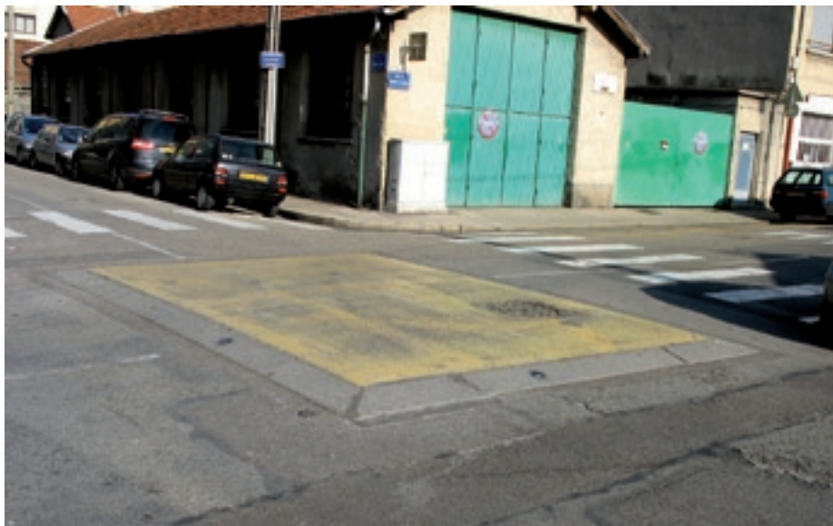
Coussin central. Grenoble n'a pas peur de faire des essais comme ici avec ce ralentisseur carré au milieu d'un carrefour. Efficace et peu coûteux. Photo: Alpes-Grenoble Métropole
