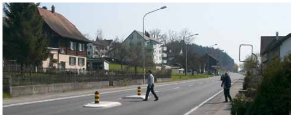
La présence d'un îlot-refuge, avec ou sans marquage de passage piéton, apporte selon la synthèse des études une bonne sécurité (photo Mobilité piétonne)
