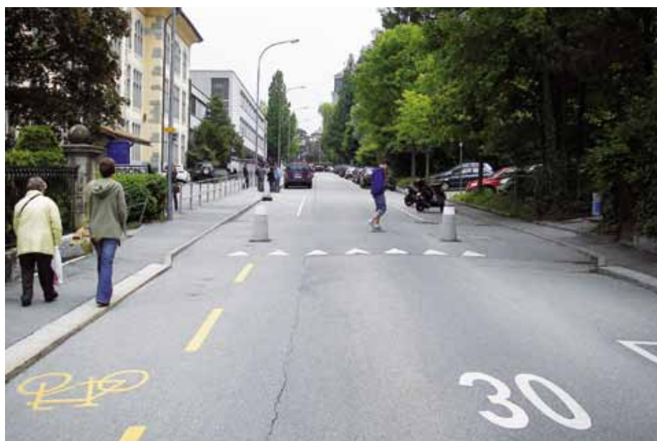
Fribourg. Rehaussement sans marquage d'un passage piéton dans une zone 30, au croisement avec une liaison piétonne transversale. Photo: D. von der Mühl
