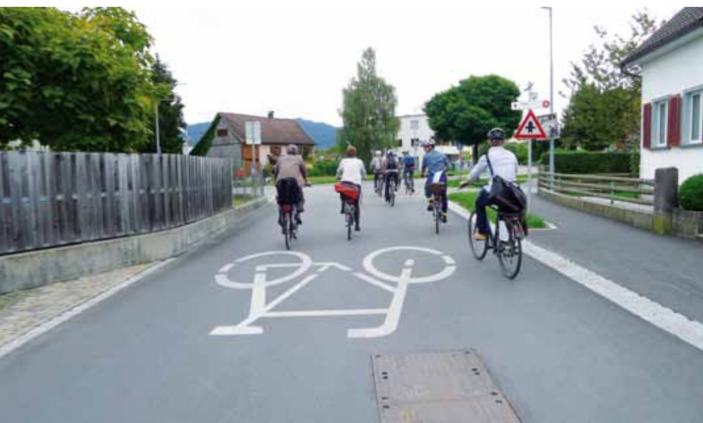
Rue cyclable dans le Vorarlberg: le marquage et la signalisation sont simples et explicites et l'itinéraire prioritaire aux intersections. En Suisse, il est prévu l'introduction d'un nouveau signal au début et à la fin des rues cyclables des projets pilotes. (Photo: Planum Biel AG)
