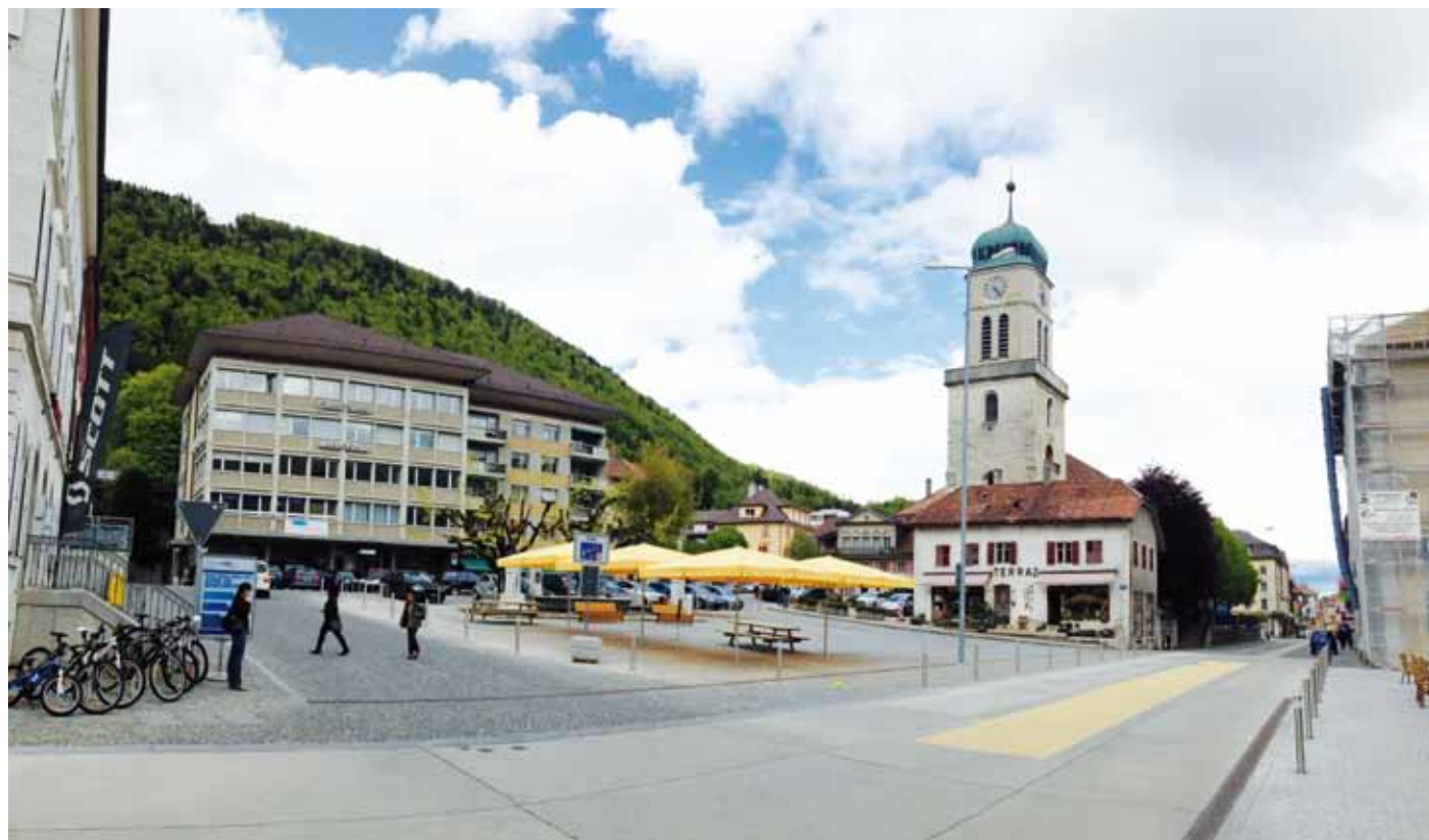
La mise à niveau de l'ensemble de la voirie et les trottoirs traversants répondent aux exigences des personnes à mobilité réduite et offrent désormais à Saint-Imier une vraie place. (Photo: RWB Groupe SA)
