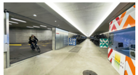
VÉLOSTATION SÉCURISÉE DANS LE PASSAGE INFÉRIEUR sous les voies de la gare de Winterthur (ZH).
