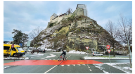
PISTE CYCLABLE EN TRAVERSÉE DE LOCALITÉ à Burgdorf (BE) avec priorité dans les carrefours.
