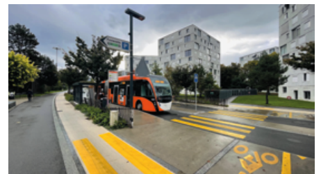
FRANCHISSEMENT D'UN ARRÊT DE BUS À CAROUGE (GE) avec une piste cyclable sécurisée.
