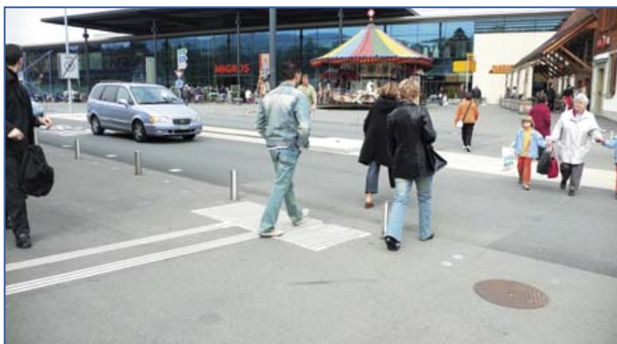
Après: des mesures coordonnées d'aménagement – giratoires aux entrées, bande polyvalente centrale – et d'abaissement de la vitesse (30 km/h) améliorent la situation de tous les usagers: les piétons, mais aussi les automobilistes et les usagers du bus (à vitesse plus lente le trafic est plus fluide et s'écoule plus rapidement).
